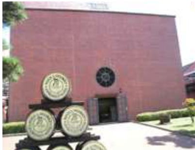
外壁タイルの補修保護工事
