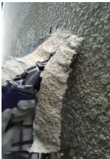
軟化した塗膜はスクレッパーで容易に剥がせる
