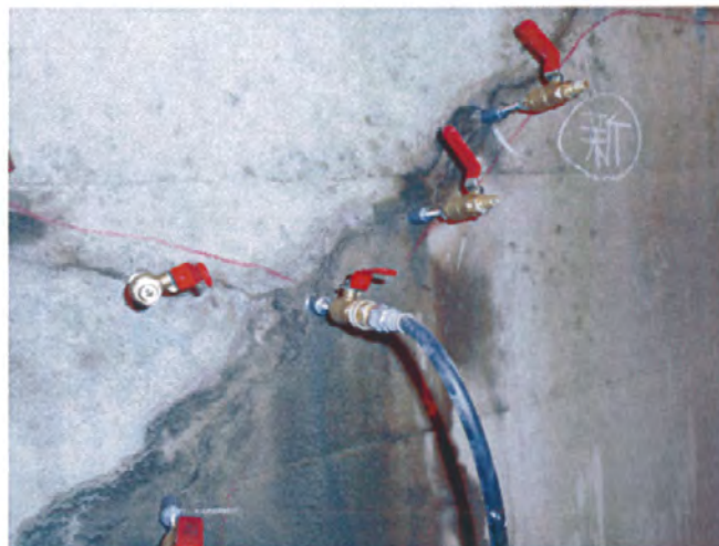
注入プラグ設置状況
