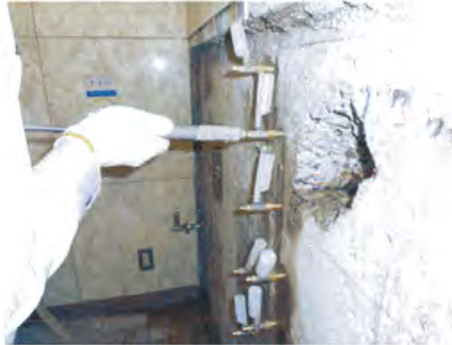
ハイドロフィット工法注入状況
