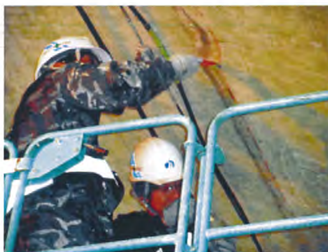
芦浜トンネル漏水補修工事
