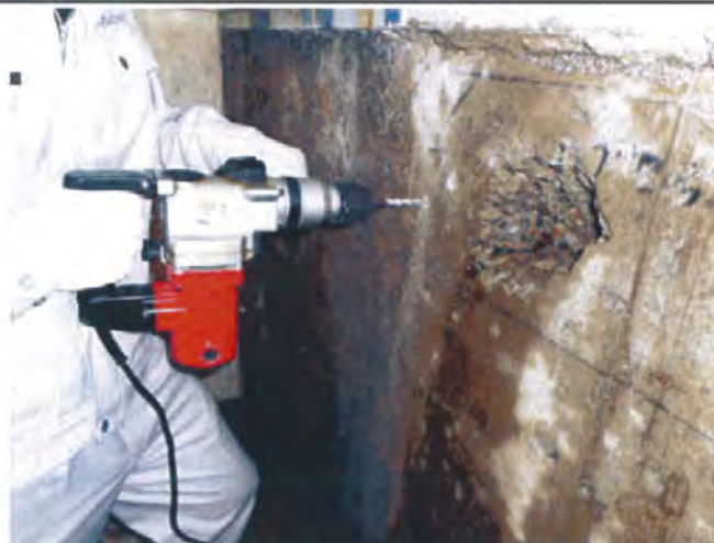
ハンマードリルで穿孔
