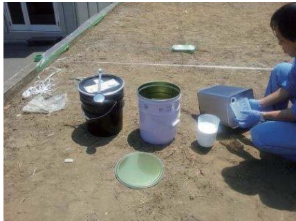
시공 준비. SKY 조치 RGH를 물로 10 배 희석. 희석 비율에 따라 건조 시간 건조 후 모래의 상태가 달라진다.
