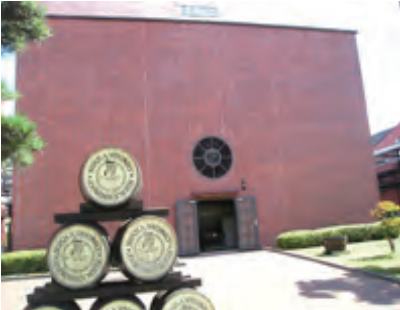
외벽 타일 보수 보호 공사
