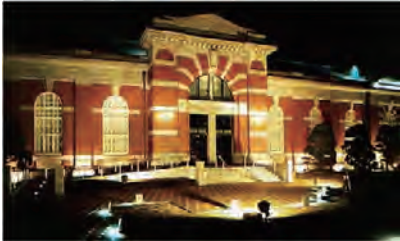
닛카 우즈키 센다이 공장 외벽 벽돌 수리 보호 공사
