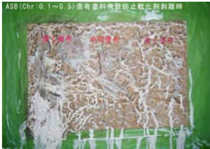
外壁にアスベスト含有塗料が含まれ、近年では塗料剥離後の解体工事が多くなってきています。
