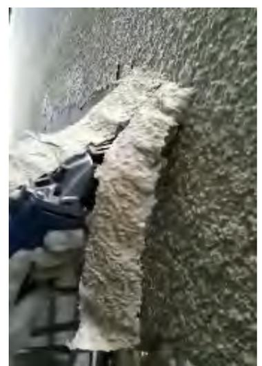
外装材や塗料にアスベストを混入することで耐久性は、はるかに向上し外装の剥がれや、色落ちが無く、特に高層ビルは極力隣地に接近して建築してきました。解体においては、外壁を利用して内部から、アスベスト処理を行いながら解体してきました。外壁塗料のアスベスト処理を先に行うためには、仮設が設置できない事もあり、特殊な施工方法が求められるようになりました。
