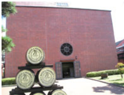
外壁タイルの補修保護工事
