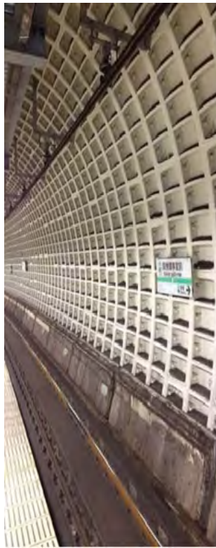
止水板を外すと地下水が溢れ出る この周辺からは毎分20ℓ以上の漏水 が出ている
