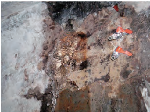
止水板を外すと地下水が溢れ出る この周辺からは毎分20ℓ以上の漏水 が出ている
