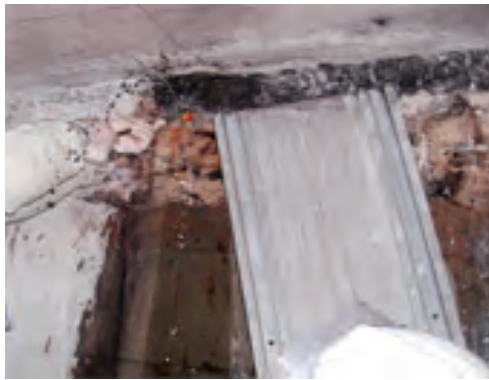
止水板を外すと地下水が溢れ出る この周辺からは毎分20ℓ以上の漏水 が出ている
