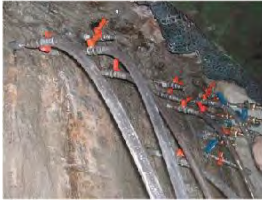
手前の透明ホースは地下水のドレーン及びリターン用
