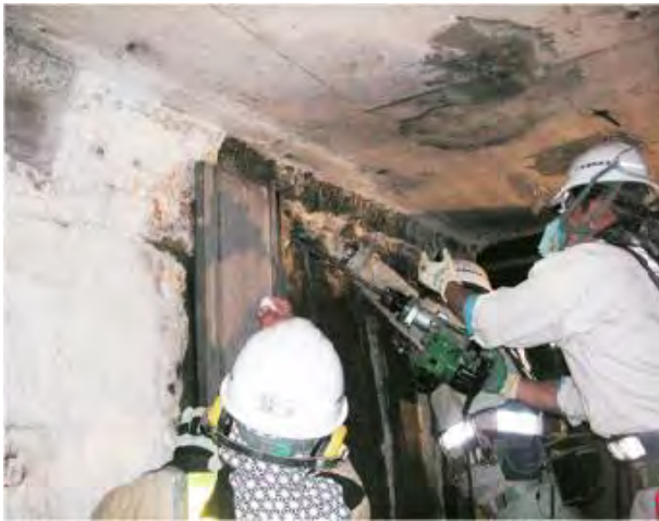
ハンマードリルで穿孔用の穴を開ける
