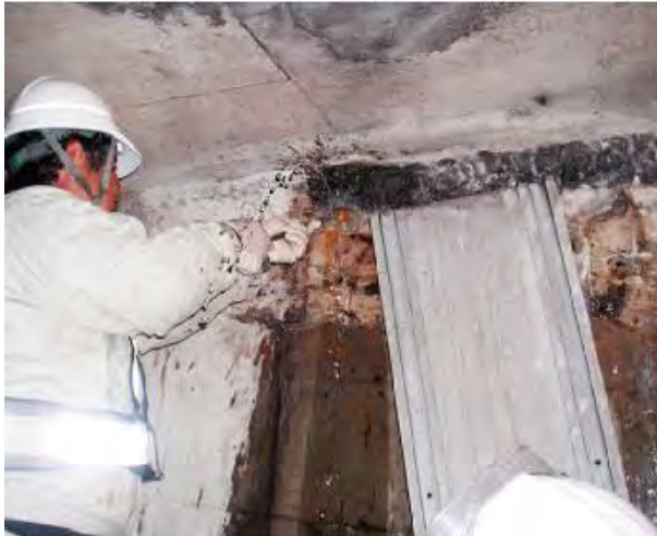
この周辺からは毎分20%以上地下水が噴きだす 止水板を外すと地下水が大量に噴きだす
