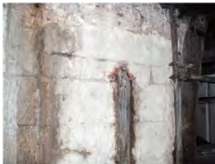
止水後、再漏水した箇所への充填
