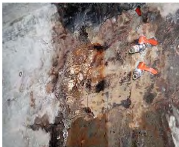
この周辺からは毎分20%以上地下水が噴きだす 止水板を外すと地下水が大量に噴きだす
