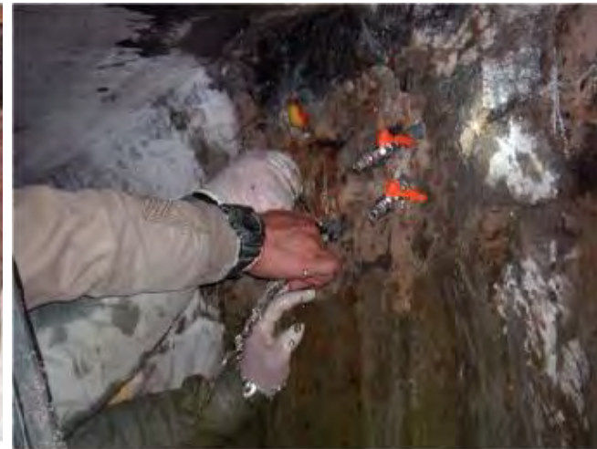
注入用プラグの取付中、周辺からは水が溢れ出る
