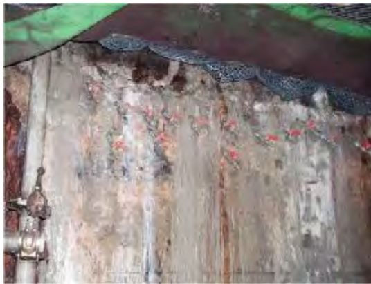
止水後、再漏水した箇所への充填
