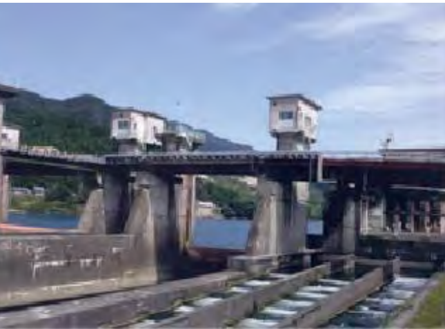
阿賀野川 左岸の魚道
