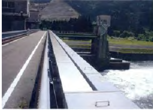
阿賀野川頭首工 施工前
