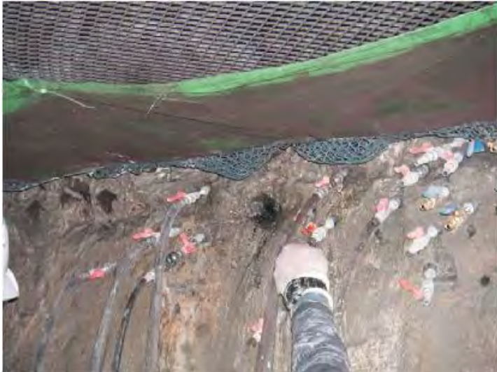
充填プラグと注入状況
