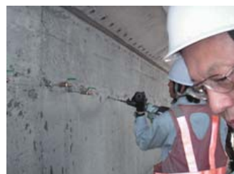
J R東海・新幹線橋脚劣化防止及び漏水補修工事
