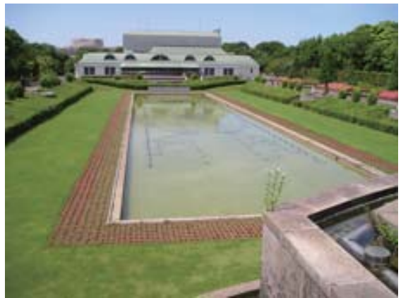
噴水池漏水補修防水工事
