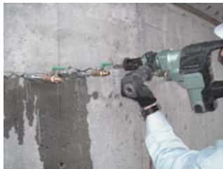
老人ホーム浴槽漏水改修防水工事
