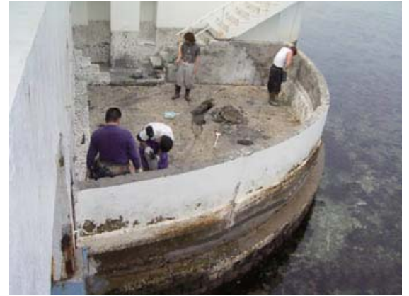
海洋迫出しプールの改修防水工事
