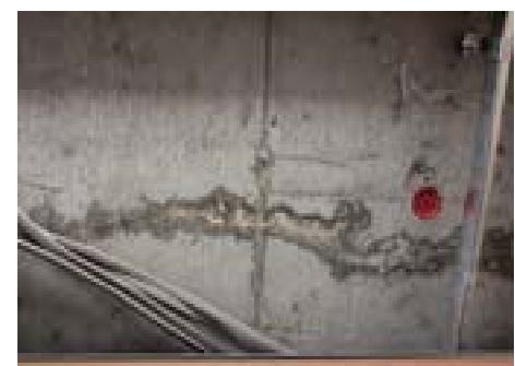
在楼下的天棚里能确认到漏水痕的时候
