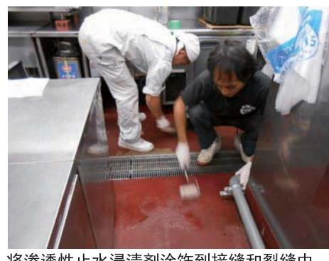
将渗透性止水浸渍剂涂饰到接缝和裂缝中
