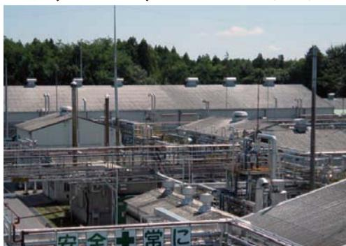
下图为工厂的石棉瓦屋顶的修复工程。建筑年龄 30 年左右。屋顶材料劣化，造成漏水的部分很多，另外还可能含有石棉纤维。高压冲洗以后，涂 **SKY-SP** 作止水处理，并让石棉纤维凝固。干燥后，涂 **SKY APOLLO MX**。依靠成分中的陶瓷空心微粒，干燥以后发挥隔热效果。干燥以后，再涂 **SKY APOLLO Silver** 而做隔热防水处理。**SKY APOLLO Silver** 的防水效果让雨水洗涤屋顶，长期继续银色的保护效果。
