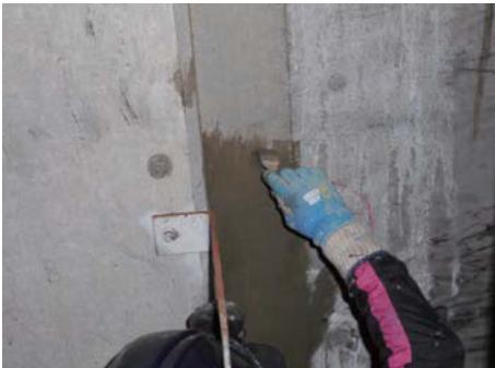
注入后，在裂缝部位涂抹灰浆
