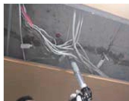
在天花板上装入插头进行注入。注入时，有时可确认到插头之间的回流，可以知道水泥浆糊在躯体内裂缝中流动，并填充到裂缝里面。
