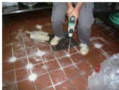
厨房到楼下的漏水补修施工
