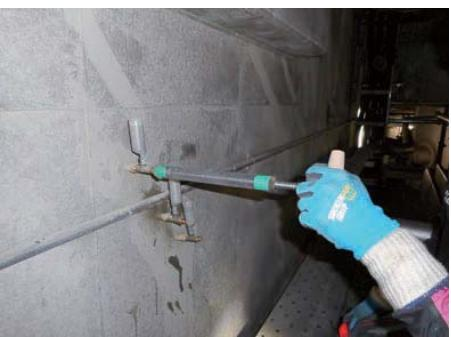
手动注入器接到灌浆插头上，开始注入
