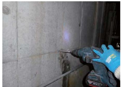
在有裂纹，裂缝的部位穿孔
