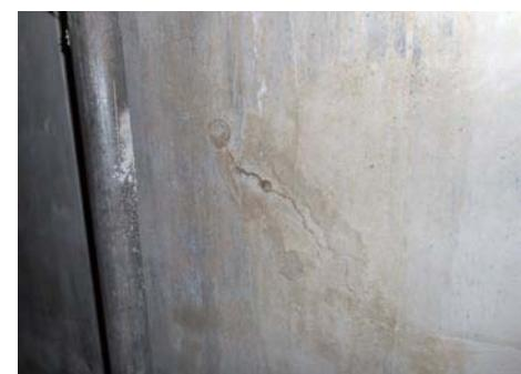
施工结束：填充到裂缝内部，不再漏水
