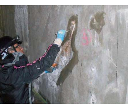
注入完工后，裂缝周围和劣化的部分，用SKY-CSP灰浆补修
